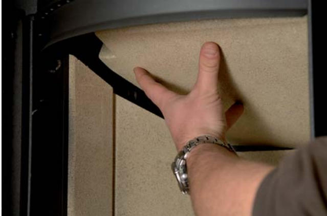
Figur 2 Einlegen der Umlenkplatte
