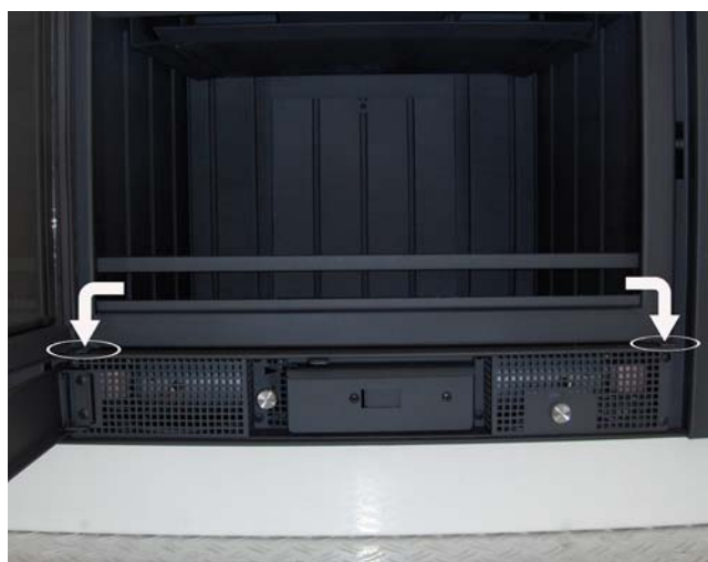
Figure 7: Enlèvement des 2 vis en bas à gauche et à droite.
