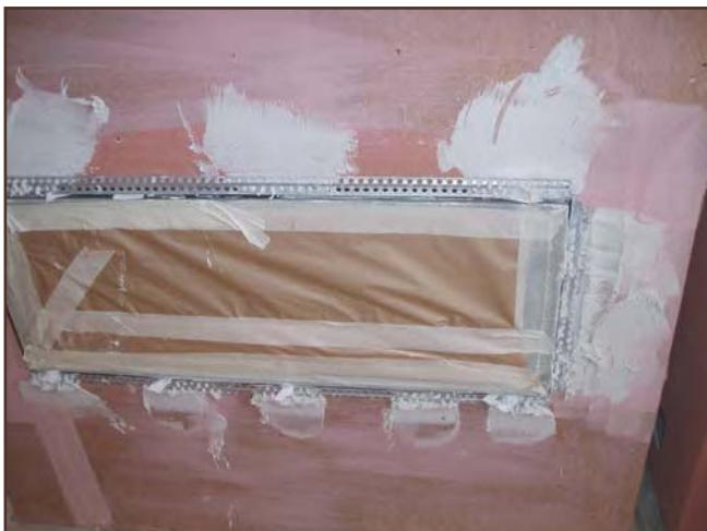
Danach werden rundum den Einbaurahmen Gipsprop- fen auf 2 mm. Abstand des Einbaurahmens befestigt.
