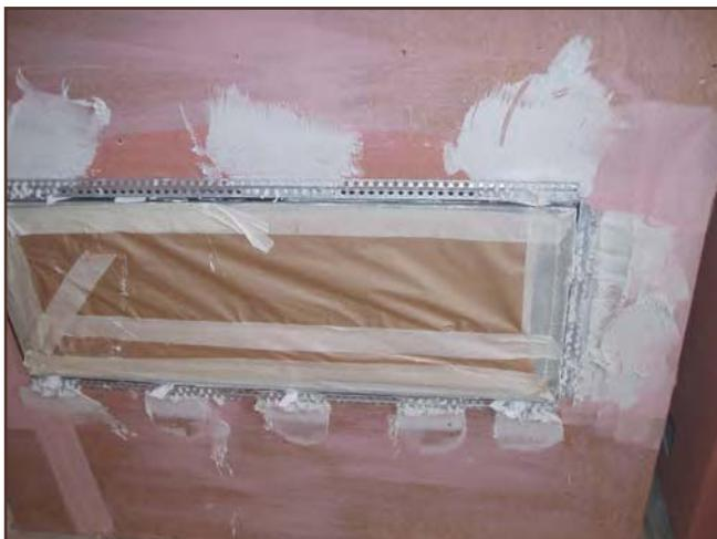
Ensuite, montez autour du cadre encastrable des protège-stuc à une distance de 2 mm du cadre encastrable.
