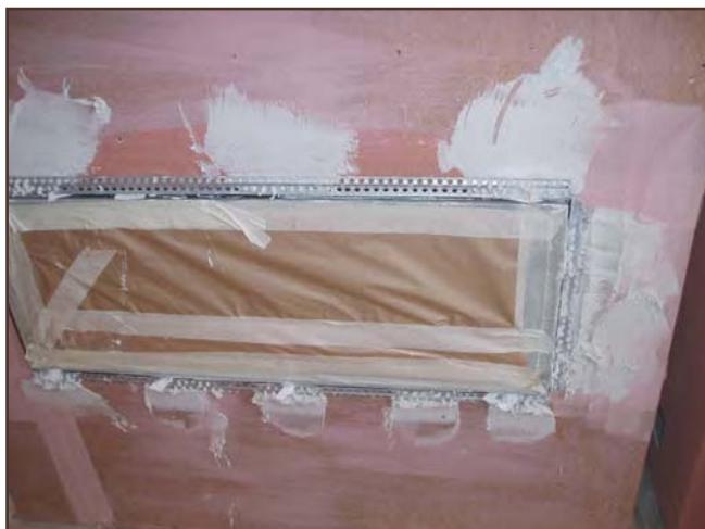
Wanneer de haard wordt ingebouwd moet de beplating rondom minimaal 5 mm vrij zijn van het inbouwkader.
